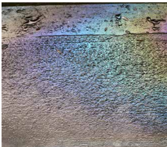
Tracce di olio motore rilasciate nell'asfalto
